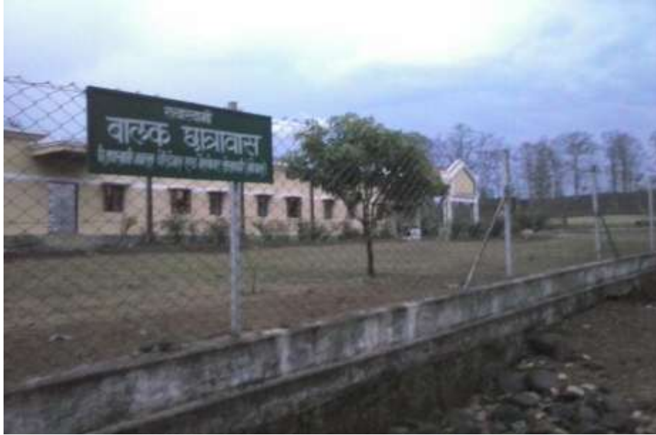
Figure: View of DEI Boys Hostel
